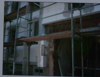
Dämmung der Außenwand
