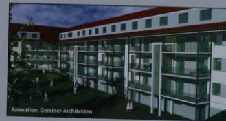
Hofansicht mit neuen Balkonen
