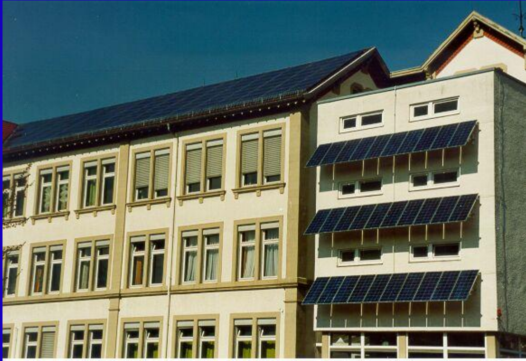
Oben: PV-Anlage auf Dach und Fassade der Kurpfalzschule
